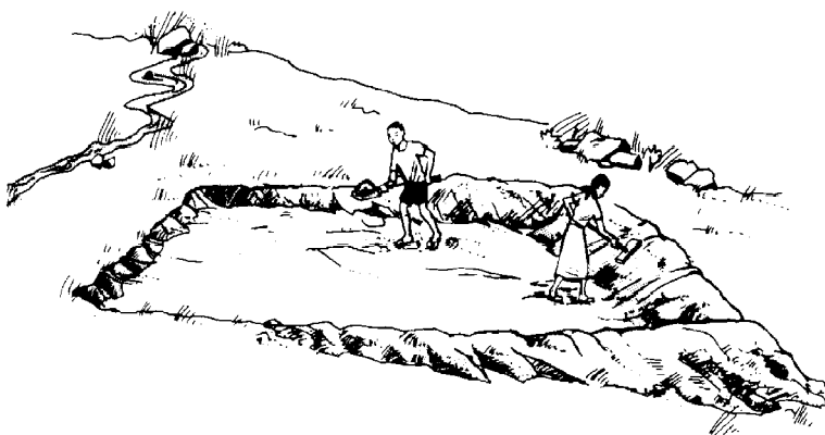
Figure 8 : Etang partiellement creusé et endigué (Murnyak, 1990)
